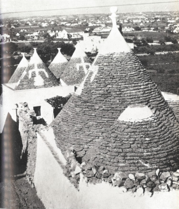
Il tetto dei trulli è costituito da una cupola costruita a calce, cioè sinterita a terra, cioè senza malta con cioli di pietra grigia della Murgia. Su questi tetti, oltre alla calce, spiccano croci e altri segni ai quali si attribuiscono poteri protettivi contro il «malocchio».
